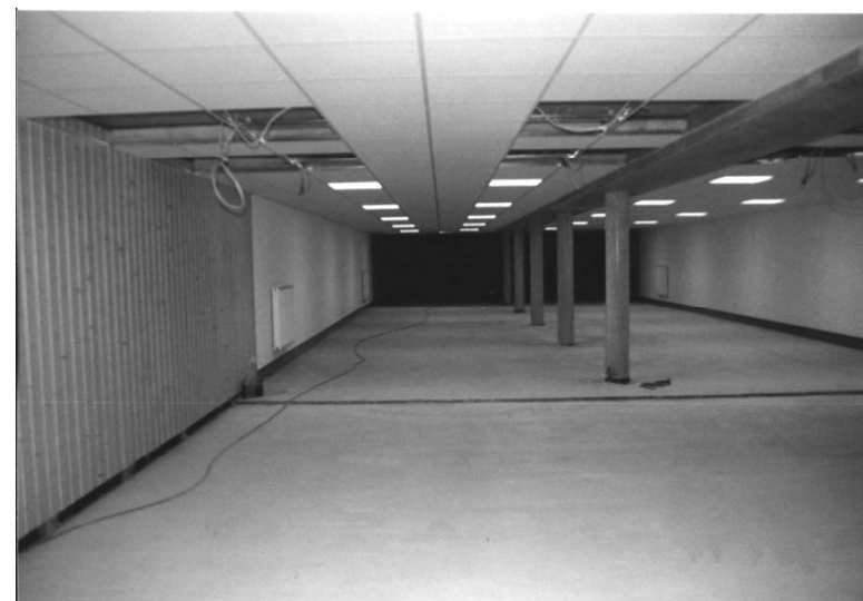
halbfertige Deckenverkleidung
