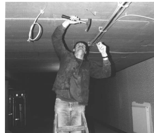
Volker Schott beim Verlegen von Kabeln
