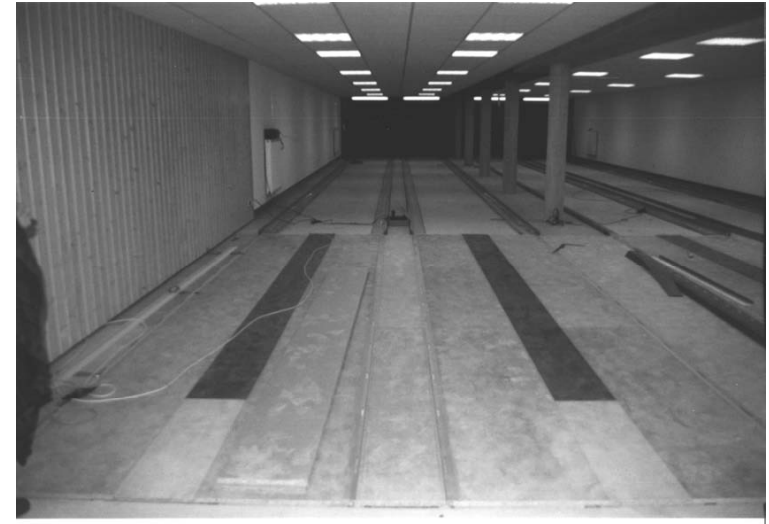
Die Unterkonstruktion für Bahn und Anlauf
